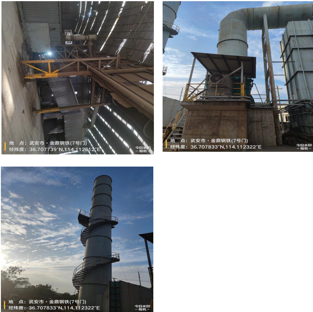
图 3-2 集尘罩+除尘器+15m 排气筒
